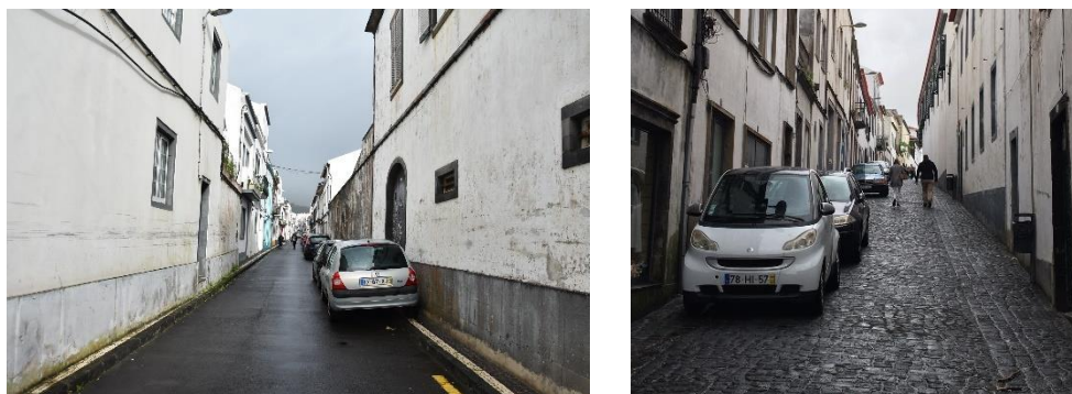
FIGURA 5.6 – EXEMPLOS DE PERFIS INADEQUADOS NOS ARRUAMENTOS DE PONTA DELGADA
